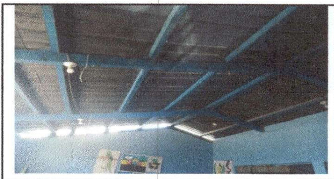
Foto 6: Sustitución de lámparas de tipo led renglón 17.3
