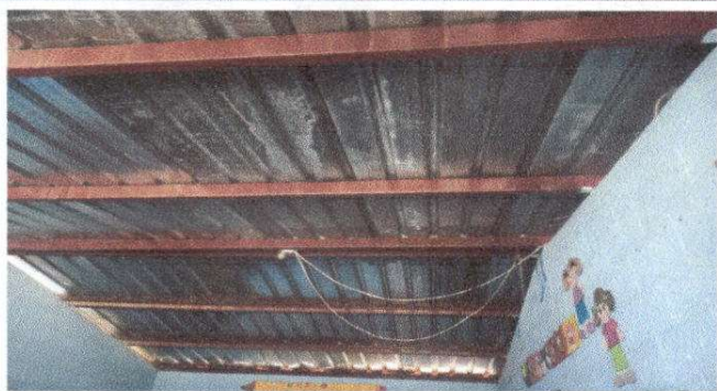
Foto1: Sustitucion de lamina por lamina troquelada renglón 1.1
